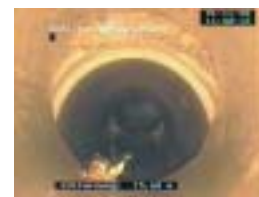
Domages causés par un affaissement du sol ou par des racines à l'intérieur de la canalisation / Schäden im Innern der Kanalisation durch Bodenabsackung oder Wurzelwuchs
