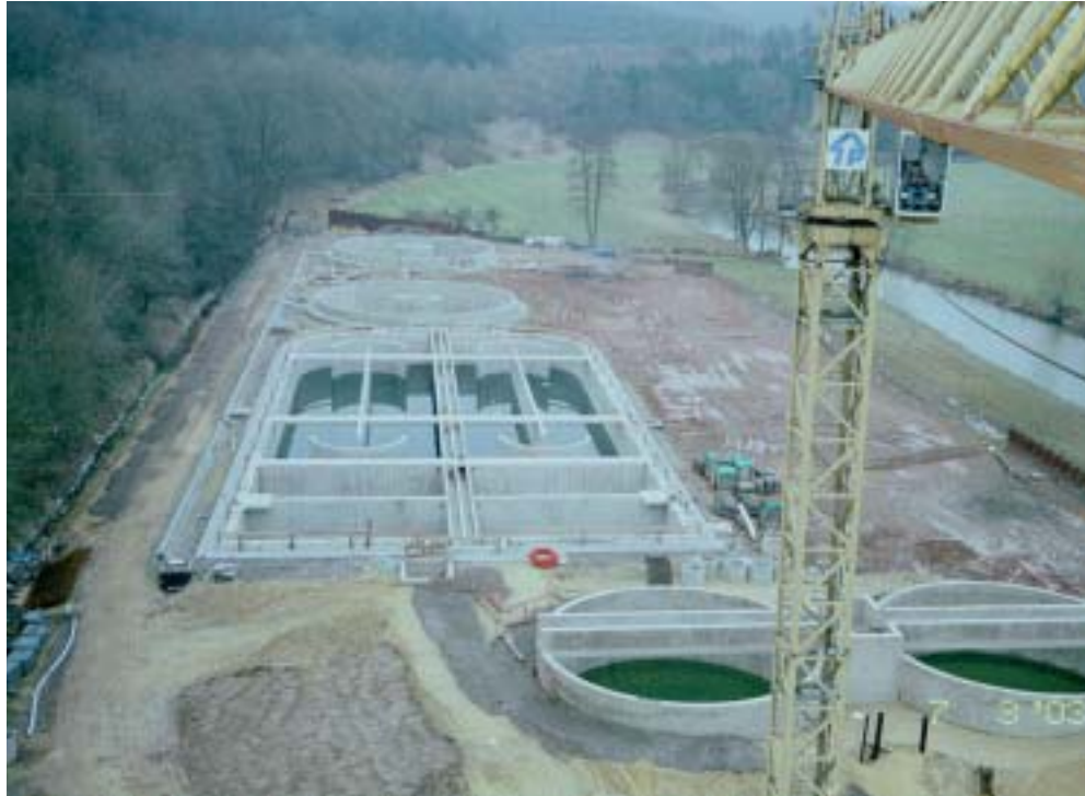
Station d'épuration de Boevange Kläranlage Boewingen
